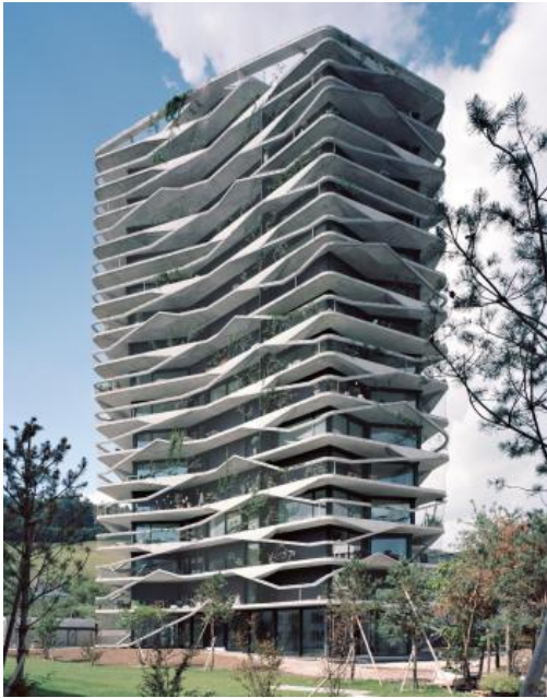
( http://cdn2.world-architects.com/files/projects/54475/images/02_136_Garden_Tower_Bern_Wabern_Daniela_Tonatiuh_Wabern.jpg ) Der Wohnturm spielt unten öffentlichen Raum frei ( Foto ©: Daniela & Tonatiuh )
