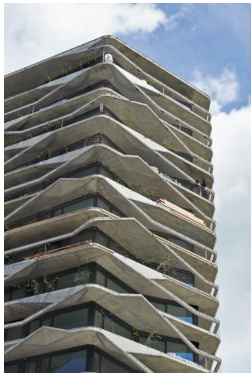
( http://cdn2.world-architects.com/files/projects/54475/images/01_136_Garden_Tower_Bern_Wabern_Daniela_Tonatiuh_001_web.jpg ) Die Fassade mit Metallbügeln, Pflanztrögen und Aufbordungen ( Foto ©: Daniela & Tonatiuh )
